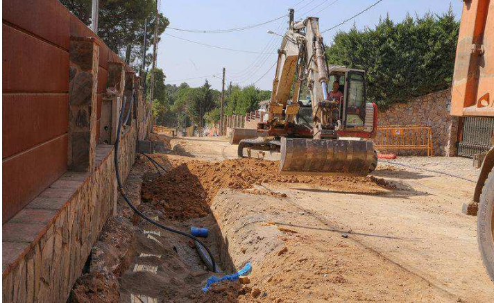
Un carrer de la urbanització Tourist Club on s'estan fent obres diverses J. SABATER.
