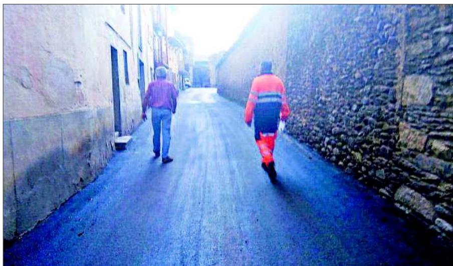
Operaris treballant en una campanya de reurbanització als nuclis agregats d'Age i Vilallobent
