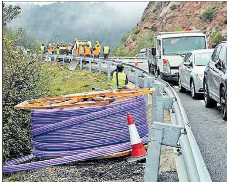
Instal·lació de la xarxa pública de fibra òptica a Cercs l'any passat
