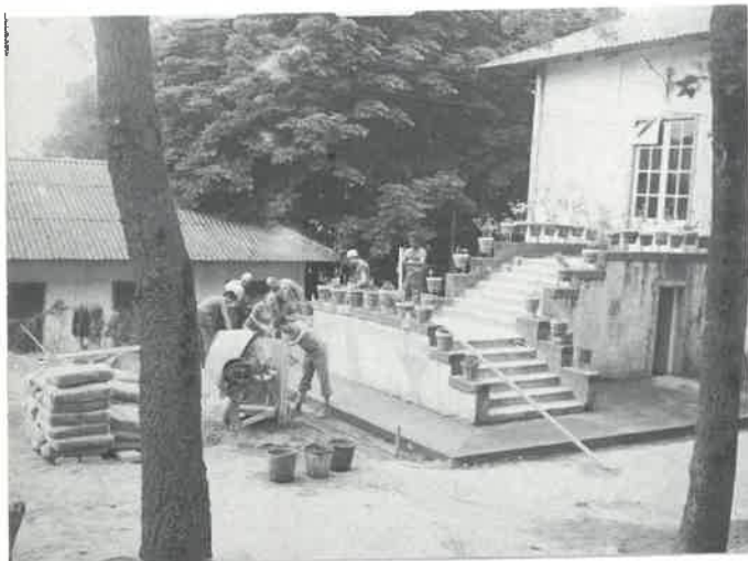
Obres en els pavellons dels "Campaments"
