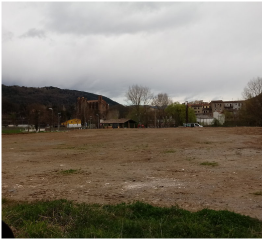
S'inicien les obres d'un pàrquing d'autocaravanes.
