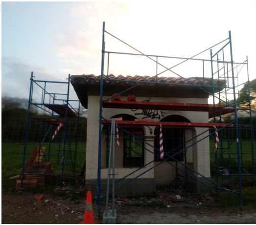
Rehabiliten la caseta dels burots J.C.
