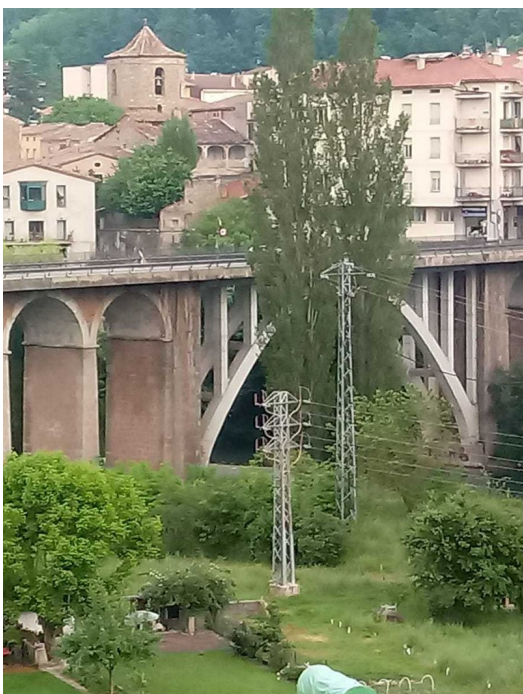
Una vista del pont Nou sobre el riu Ter de Sant Joan de les Abadesses, amb el nucli històric de rerefons J.C.
