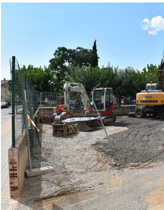
Un moment dels treballs al pati de L'Entorn per fer-hi la pista poliesportiva R.E.
