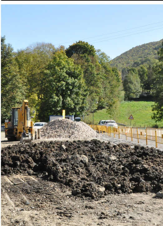
Aspecte de les obres que s'estan executant al costat de la C-38, la carretera de coll d'Ares CONSELL COMARCAL DEL RIPOLLÈS.
