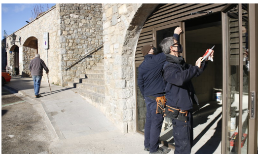
Dos operaris, en els treballs d'adequació del futur caixer automàtic de Llanars, al Ripollès. L.C. / ACN.
