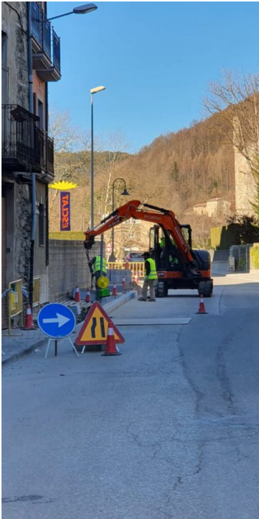
Les obres del carrer Freixenet afecten el costat esquerre J.C.
