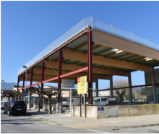
Aspecte de la futura pista coberta, que s'està aixecant al pati de l'escola L'Entorn R.E.
