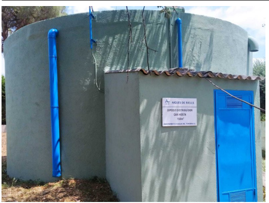
Un dels dipòsits d'aigua del municipi, en aquest cas el de la urbanització de Can Hosta AJ. RIELLS I VIABREA.
