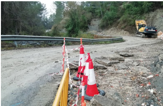
Una de les zones que estan en obres, aahir al matí R.E.
