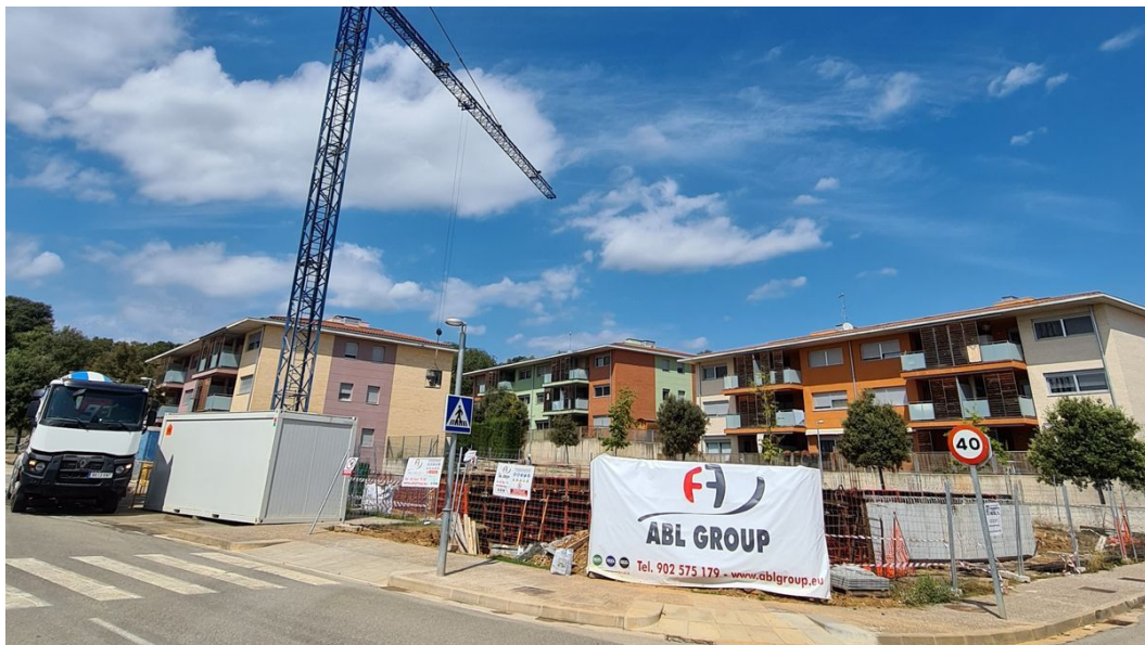
Les obres duraran aproximadament 15 mesos / AJUNTAMENT DE SANT GREGORI
