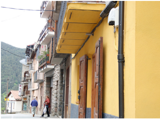
Un carrer de Planoles amb la caixa instal·lada de fibra òptica. ACN.
