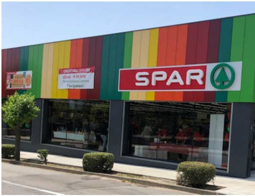
Façana del nou supermercat Spar de les Planes EPA.
