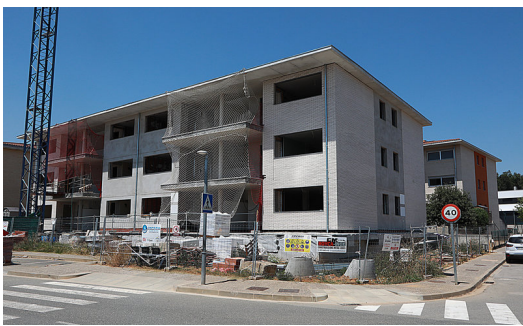
Estat actual de les obres dels habitatges de protecció oficial de Sant Gregori MANEL LLADÓ.
