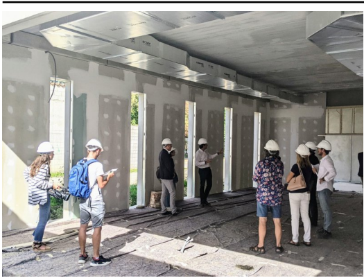
Visita de les obres d'Àltima al nou tanatori de Sant Joan de les Abadesses CEDIDES.
