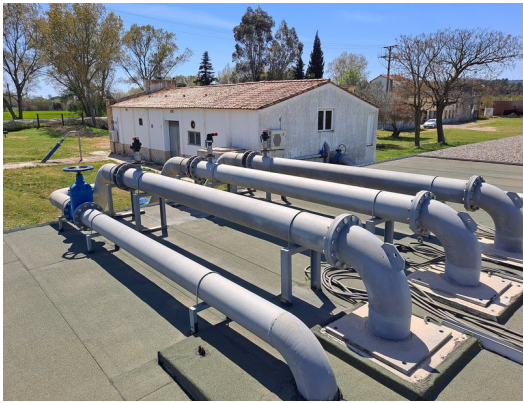
L'edifici de l'estació de bombament dels pous de Torrent abans que es construís l'ETAP ACN.
