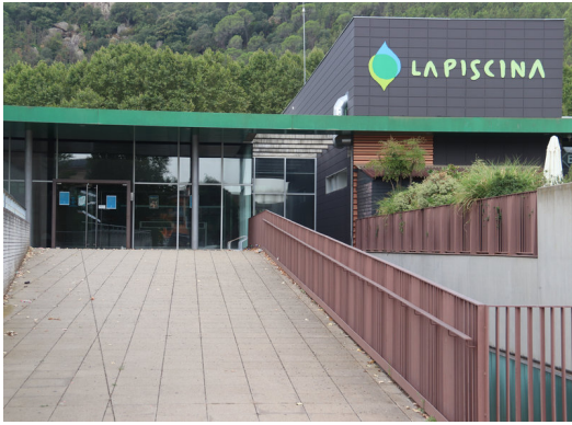
Façana de la piscina coberta tancada a l'agost. ACN.
