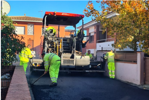
Diversos treballadors asfaltant els carrers de Sant Gregori CEDIDA.
