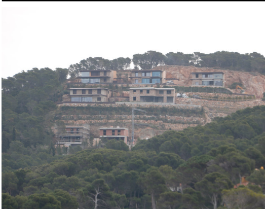
Les cases que s'estan construint a la zona de s'Antiga ACN.
