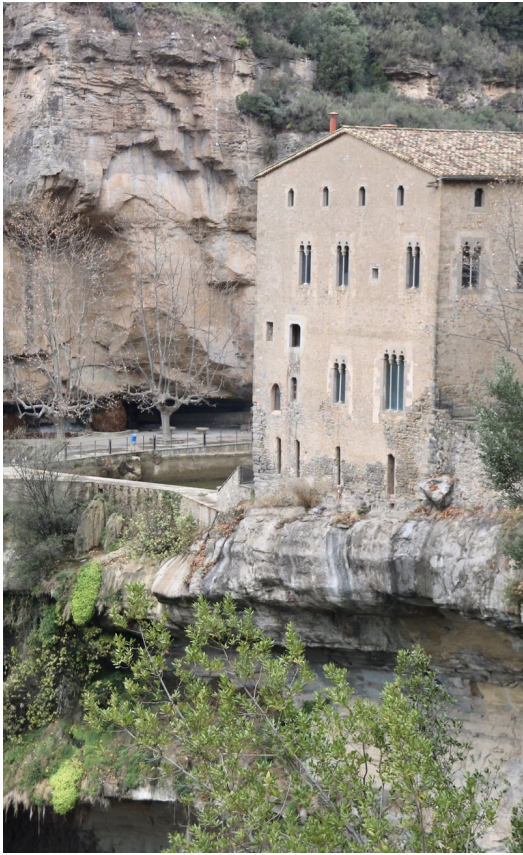
La casa prioral, situada a la zona d'obres ACN.
