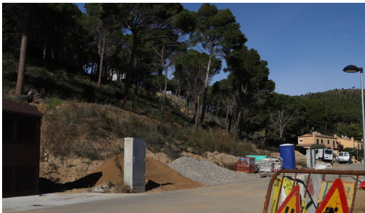
Obres al sector de Montcal, un altre dels fronts oberts de SOS Costa Brava a Begur E.A.
