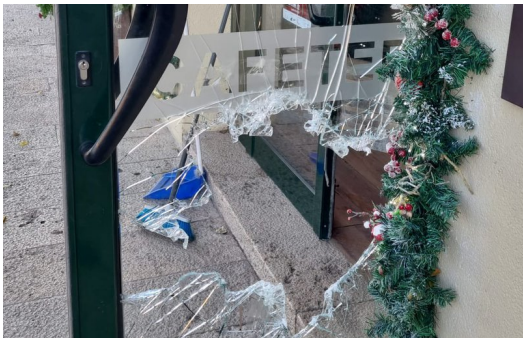
Estat en què va quedar la porta del castell de Besalú VIU BESALÚ.
