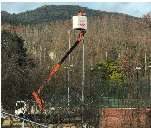
Treballs de substitució dels punts de llum en un carrer del municipi AJUNTAMENT D'ARBÚCIES.
