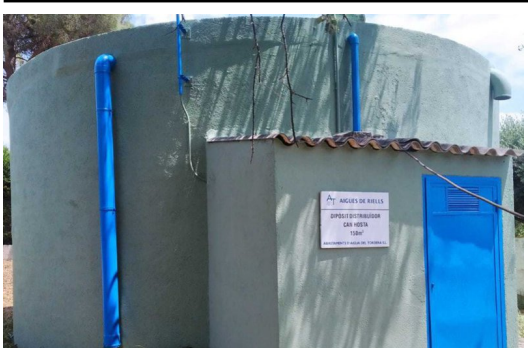
Un dels dipòsits de la xarxa de distribució AJUNTAMENT DE RIELLS I VIABREA.
