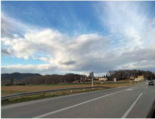
L'actual C-152 al sector afectat per la rotonda nord J.C.
