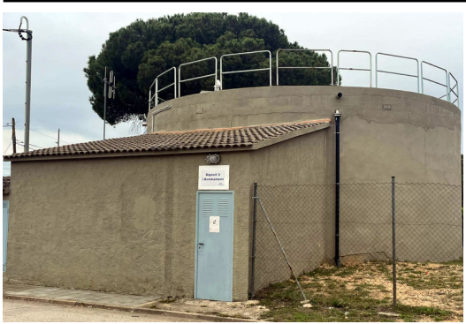
Un dels dipòsits d'aigua que abasteixen la xarxa de distribució de Santa Coloma ACN.
