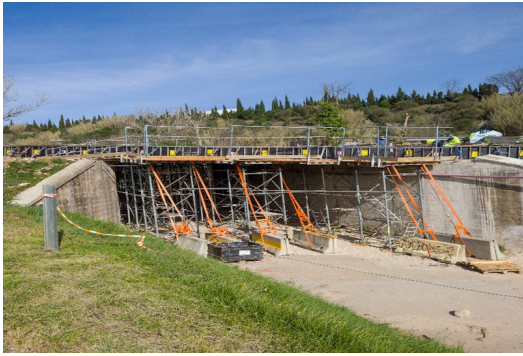
Pla general del pont sobre el Ter que s'ha reparat ACN.
