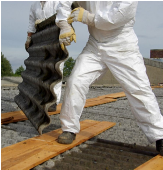
Operaris retirant amiant AJ. TORROELLA.
