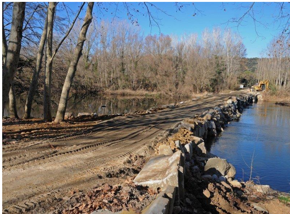
Reconstrucció de la passarel·la després de les pluges de la tardor del 2018 PERE MAGRIÀ.
