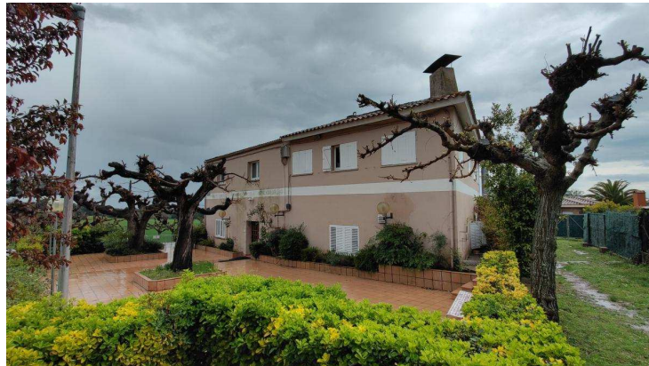
L'edifici La Sala es rehabilitarà. Aj. de Canet d'Adri.
