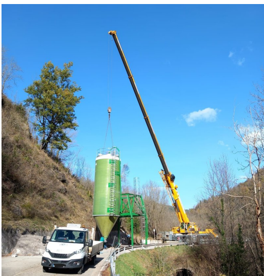
La nova sitja de sal al km 9 de la C-38, al terme municipal de Camprodon. GENERALITAT DE CATALUNYA.
