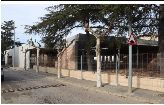
El futur centre de dia de Vidreres ACN.
