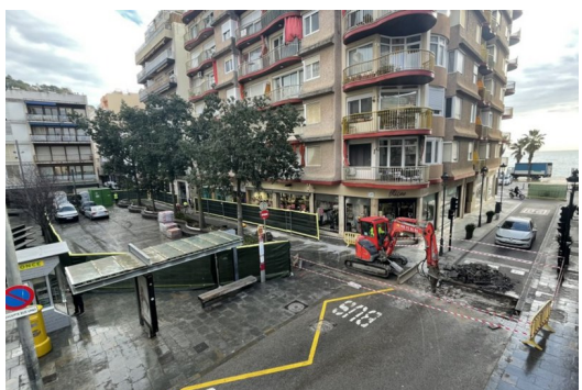
Primers treballs de millora de la xarxa pluvial al nucli antic AJUNTAMENT DE BALNES.
