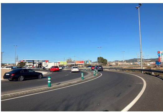
L'obra preveu abolir la rotonda de la C-65 . AJUNTAMENT DE SALT.
