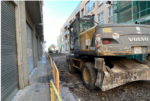
Les obres ja han començat. CEDIDA.
