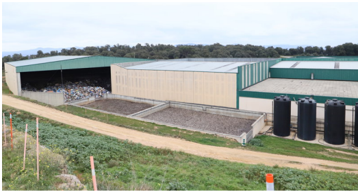
Planta de recepció, pretriatge, transferència i compostatge de Solius, que l'ARC vol rehabilitar a banda del dipòsit clausurat E.A.
