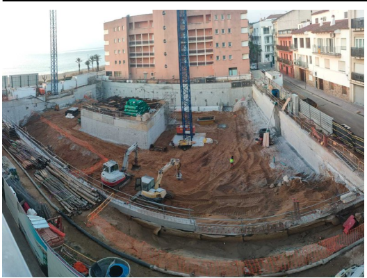
Vista aèria de les obres, amb una de les bombes a la part dreta del solar EPA.
