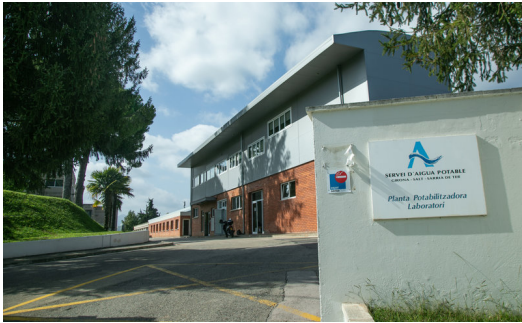
L'exterior de la planta potabilitzadora de Montfullà (Besanó), l'octubre del 2022. QUIM PUIG.
