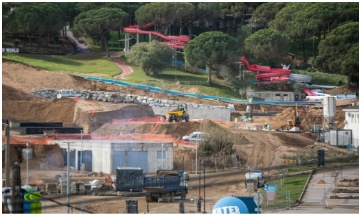
Obres d'ampliació que es porten a terme a Water World, a Lloret QUIM PUIG.
