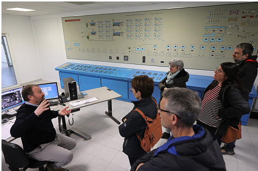
Ramon Gasull (Catsa), assegut, explicant com funciona la planta, a la sala de control de Montfullà, ahir a la tarda. MANEL LLADÓ.
