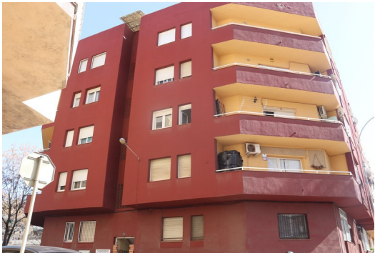
La façana de l'edifici afectat. ACN.
