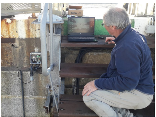
Procés d'instal·lació del mareògraf al port de Palamós AJUNTAMENT DE PALAMÓS.
