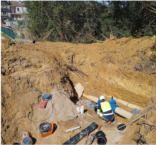
La rasa, amb els operaris treballant-hi, per connectar el nou dipòsit del puig Negre a la xarxa general d'abastament de la Bisbal AJ. LA BISBAL.
