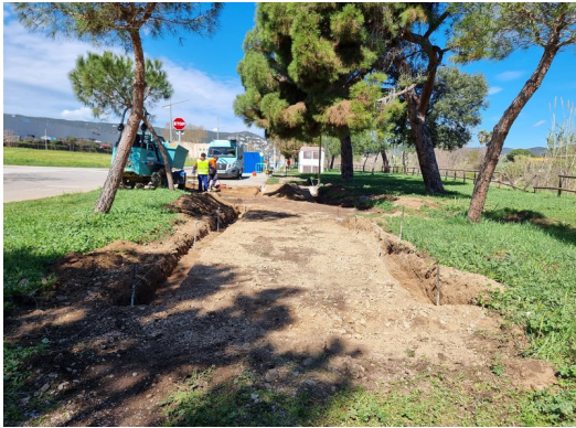
Inici de les obres de la via verda AJUNTAMENT DE CALONGE.
