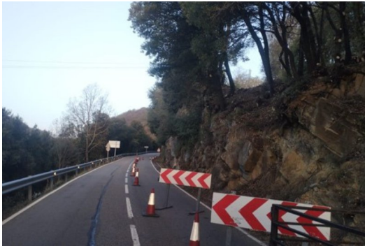
Obres de protecció de talussos a la N-260a DEPARTAMENT DE TERRITORI.
