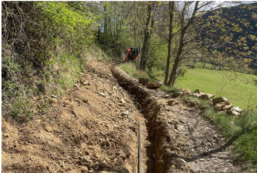
Treballs per reparar la fuga d'aigua detectada a Planoles. CEDIDA.
